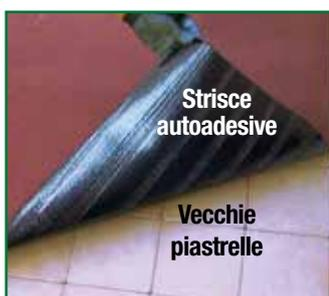
Si esercita una pressione adeguata sulla metà del rotolo dove si è rimosso il film siliconato per realizzare l'adesione al supporto. Successivamente si rimuove l'altra metà del film siliconato della faccia inferiore e si pressa adeguatamente il foglio intero.
